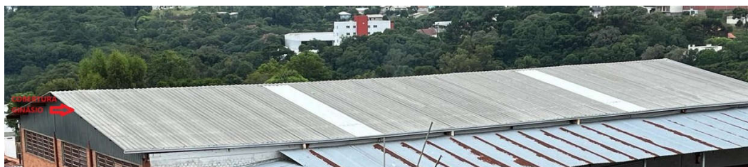
Figura 1: Cobertura do ginásio existente
