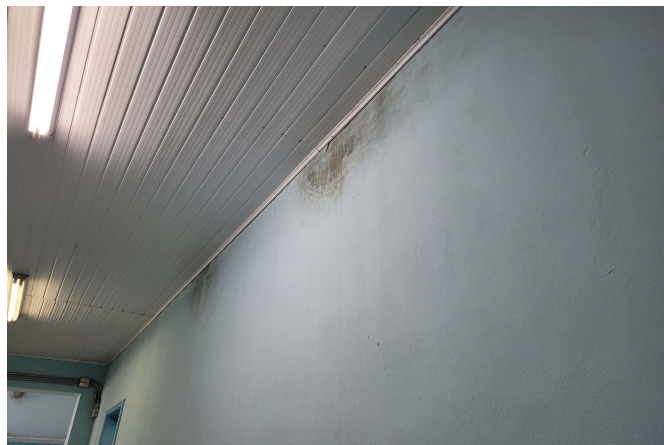
Foto 02 – Umidade parede
