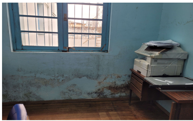
Foto 06 – Infiltração
