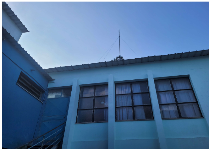
Foto 08 – Telhado Prédio “C”
