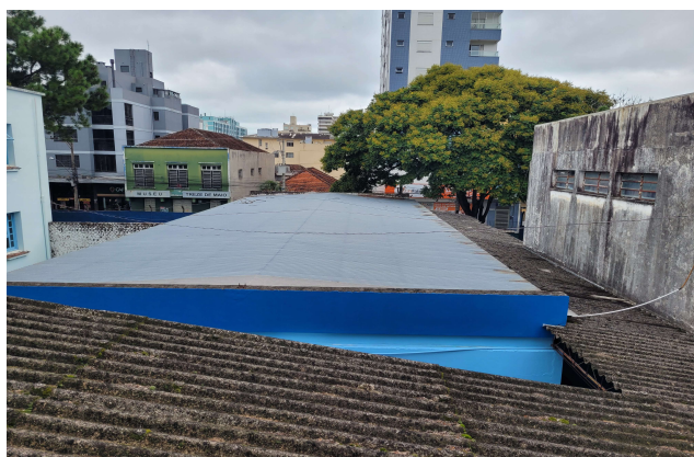
Foto 05 – Telhado Bloco “C”
