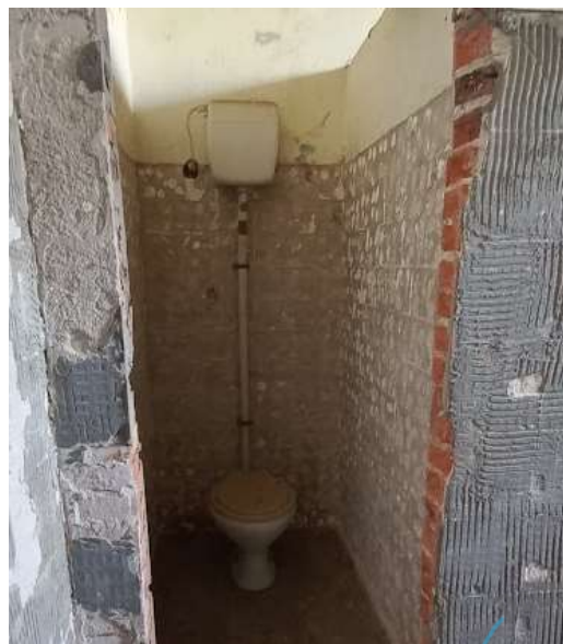
Figura 31: Sanitários primeiro pav. (Fotos 11/2023).
