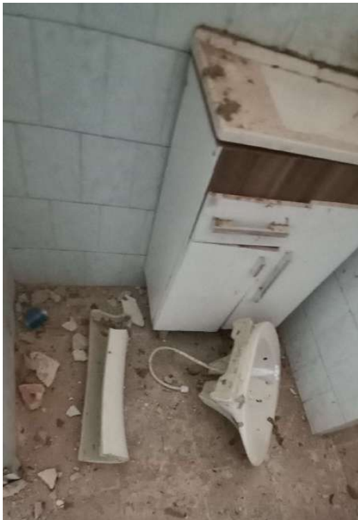
Figura 28: Sanitários primeiro pav. (Fotos 11/2023).
