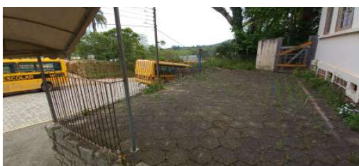
Figura 23: Pavimentação acesso da escola (Fotos 11/2023).
