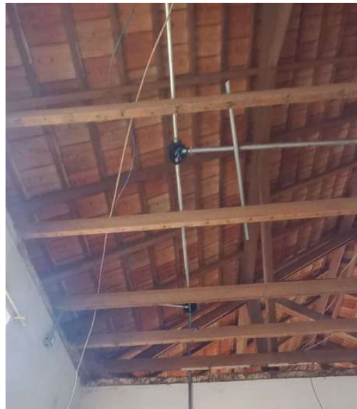
Figura 18: Forro removido salas de aula (Fotos 11/2023).
