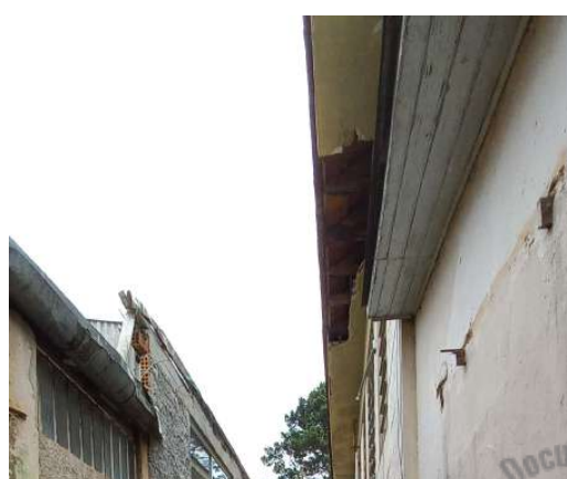
Figura 10: Beirado lateral direita acesso principal (Fotos 11/2023).
