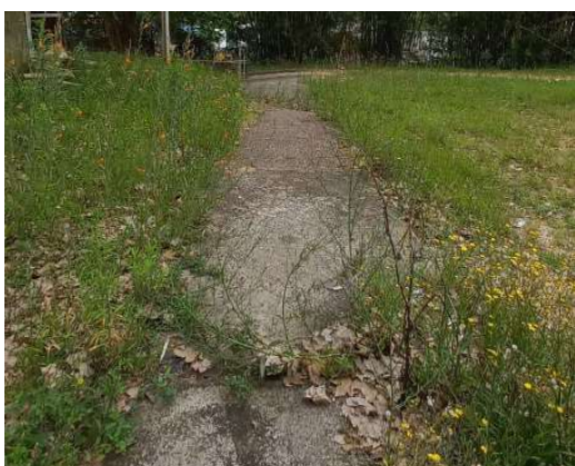
Figura 46: Acesso PcD (Fotos 11/2023).
