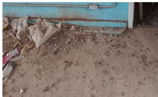
Figura 22: Piso sala de aula (Fotos 11/2023).
