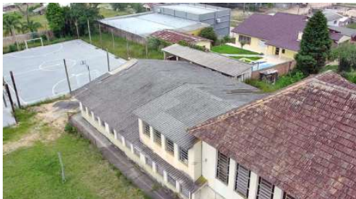
Figura 5: Cobertura (Fotos de drone 11/2023).
