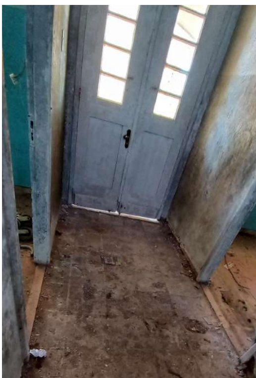
Figura 61: Hall de entrada da escola (Fotos 11/2023).
