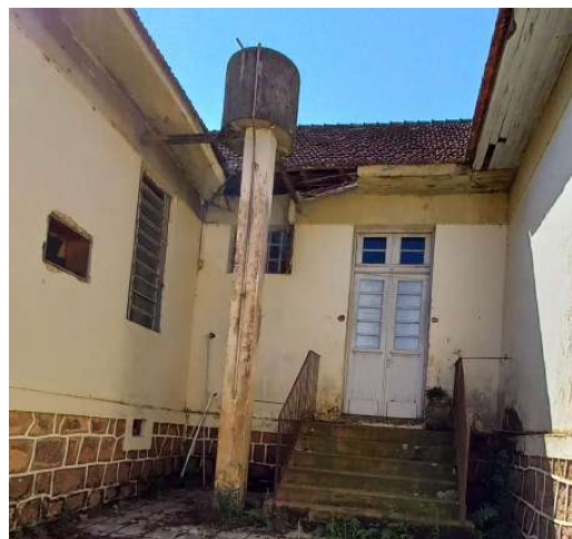
Figura 70: Reservatório sobre a circulação em frente aos sanitários do primeiro pavimento (Fotos 11/2023). Figura 71: Reservatório antigo (Fotos em frente aos sanitários do primeiro 11/2023).
