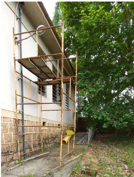
Figura 48: Rampa existente (Fotos 11/2023).
