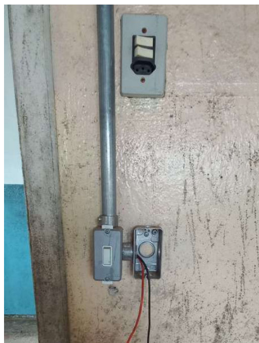
Figura 26: interruptor instalado durante a reforma da demanda anterior (Fotos 11/2023).
