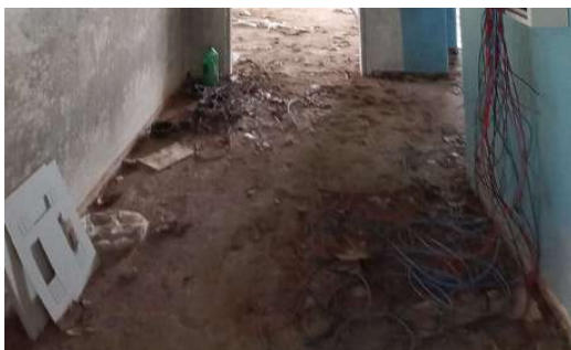
Figura 21: Circulação com piso removido (Fotos 11/2023).
