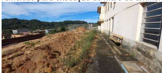
Figura 78: Pátio da escola com solo remexido para execução do muro de arrimo.
