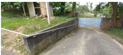
Figura 42: Acesso de PcD realizado pela entrada de veículos (Fotos 11/2023).
