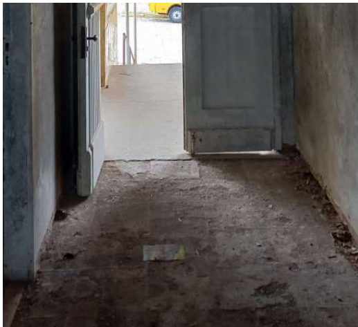
Figura 19: Hall de entrada da escola com piso removido (Fotos 11/2023).
