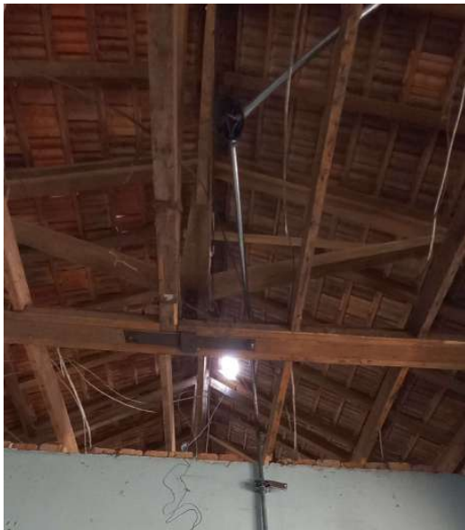
Figura 17: Forro removido salas de aula (Fotos 11/2023).
