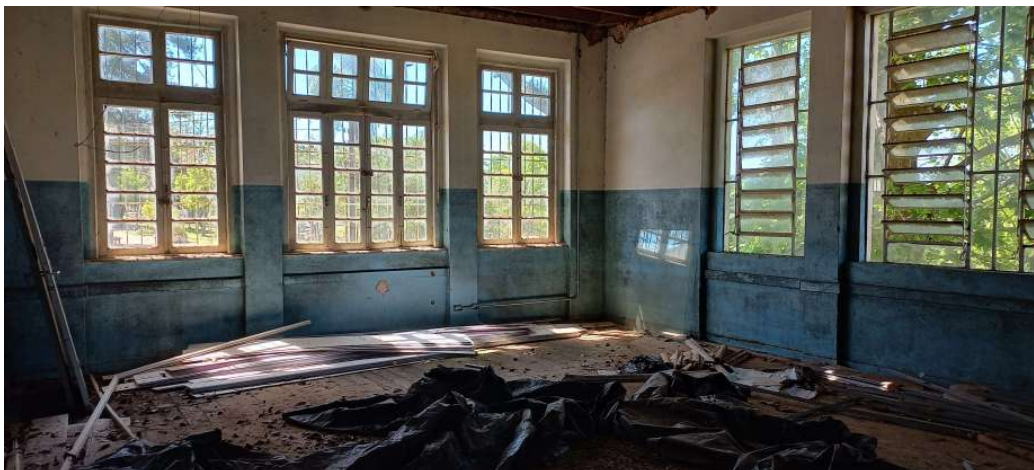
Figura 63: Sala de aula primeiro pav. (Fotos 11/2023).
