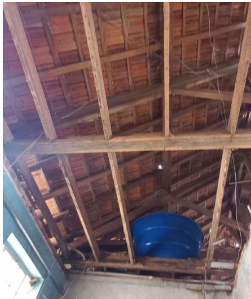
Figura 12: Madeiramento circulação de acesso a escola (Fotos 11/2023).
