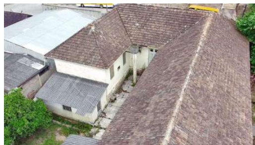
Figura 2: Cobertura salas de aula (Fotos de drone 11/2023).
