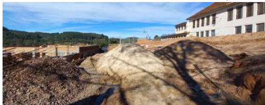
Figura 76: Pátio da escola com solo remexido para execução do muro de arrimo.
