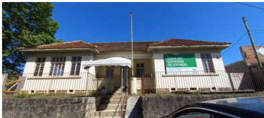
Figura 40: Rampa de acesso entrada da escola em desacordo com a norma (Fotos 11/2023).
