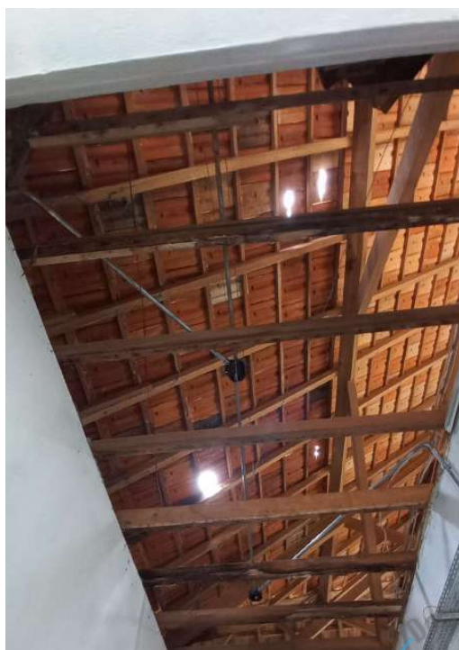
Figura 14: Madeiramento circulação (Fotos 11/2023).
