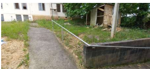
Figura 44: Rampa de acesso à edificação. (Fotos 11/2023).
