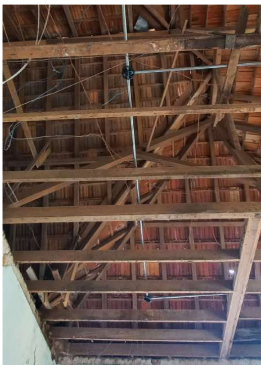
Figura 13: Madeiramento sala de aula (Fotos 11/2023).
