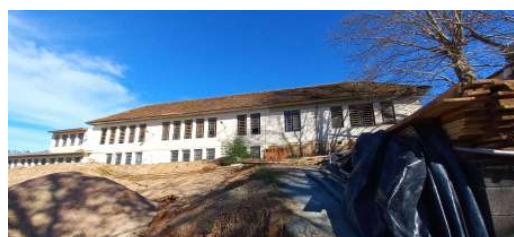
Figura 45: Rampa de acesso à edificação a ser reconstruída pelo vizinho.
