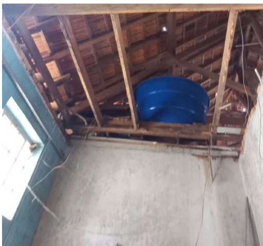
Figura 70: Reservatório sobre a circulação em frente aos sanitários do primeiro pavimento (Fotos 11/2023). Figura 71: Reservatório antigo (Fotos em frente aos sanitários do primeiro 11/2023).
