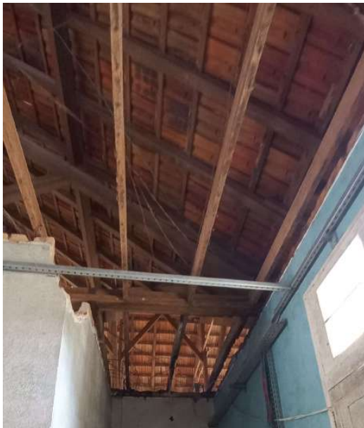
Figura 11: Madeiramento circulação de acesso a escola (Fotos 11/2023).
