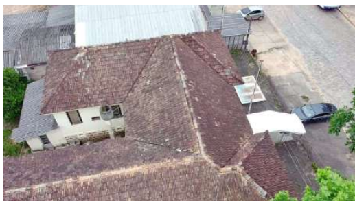
Figura 1: Cobertura acesso principal (Fotos de drone 11/2023).
