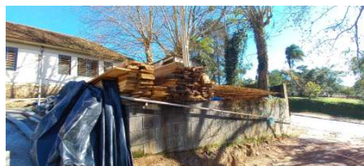
Figura 43: Acesso de PcD a ser reconstruído pelo vizinho.
