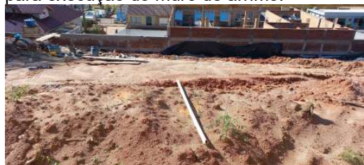
Figura 79: Pátio da escola com solo remexido para execução do muro de arrimo.
