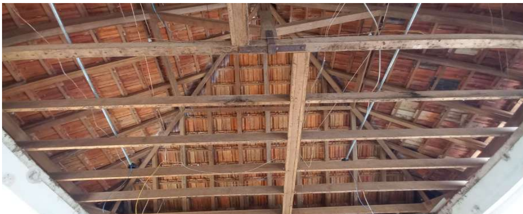
Figura 27: Espera iluminação instalada durante a reforma da demanda anterior (Fotos 11/2023).
