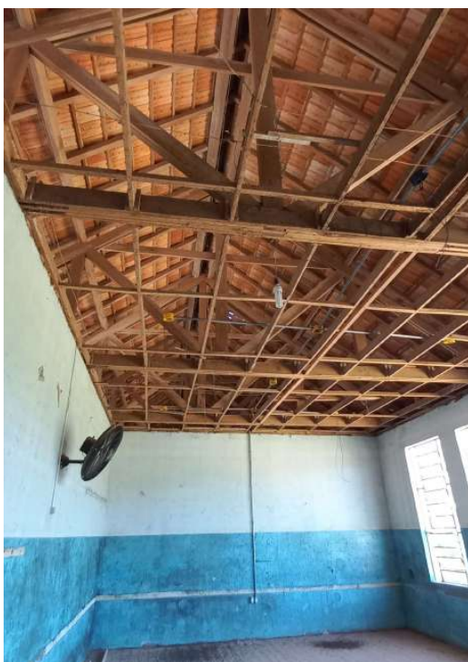
Figura 64: Sala de aula primeiro pav. (Fotos 11/2023).
