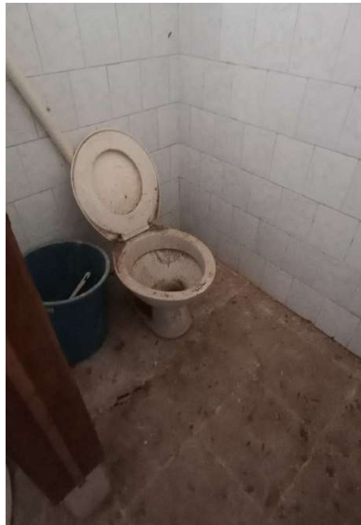
Figura 29: Sanitários primeiro pav. (Fotos 11/2023).
