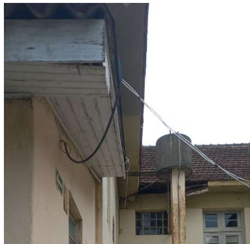
Figura 8: Beirado lavanderia e fundos do acesso principal (Fotos 11/2023).
