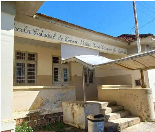
Figura 55: Fachada principal da escola (Fotos 11/2023).
