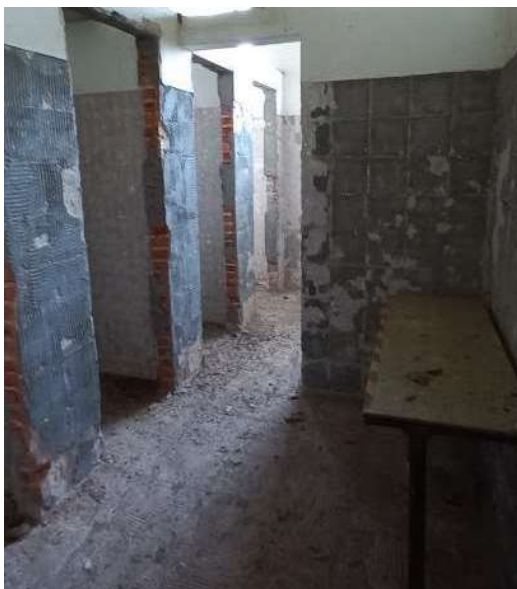
Figura 30: Sanitários primeiro pav. (Fotos 11/2023).
