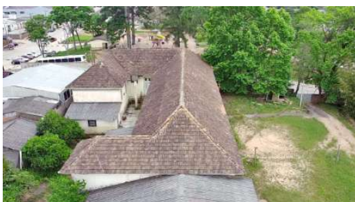
Figura 3: Cobertura (Fotos de drone 11/2023).
