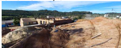
Figura 77: Pátio da escola com solo remexido para execução do muro de arrimo.
