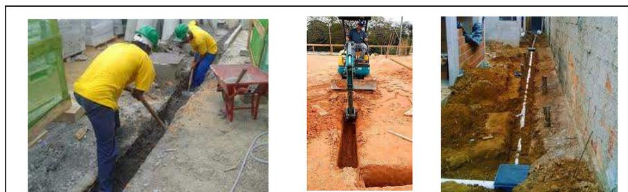
Figura 5- ilustrações genéricas de abertura de valas para instalação da tubulação de esgoto
