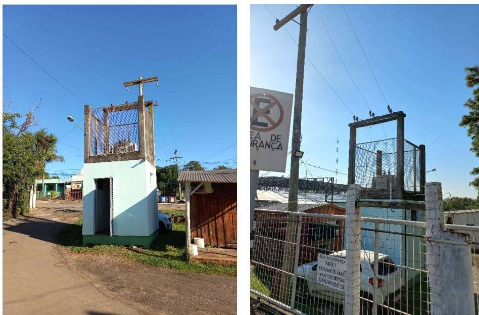
Figura 02 e 03- Localização da subestação existente
