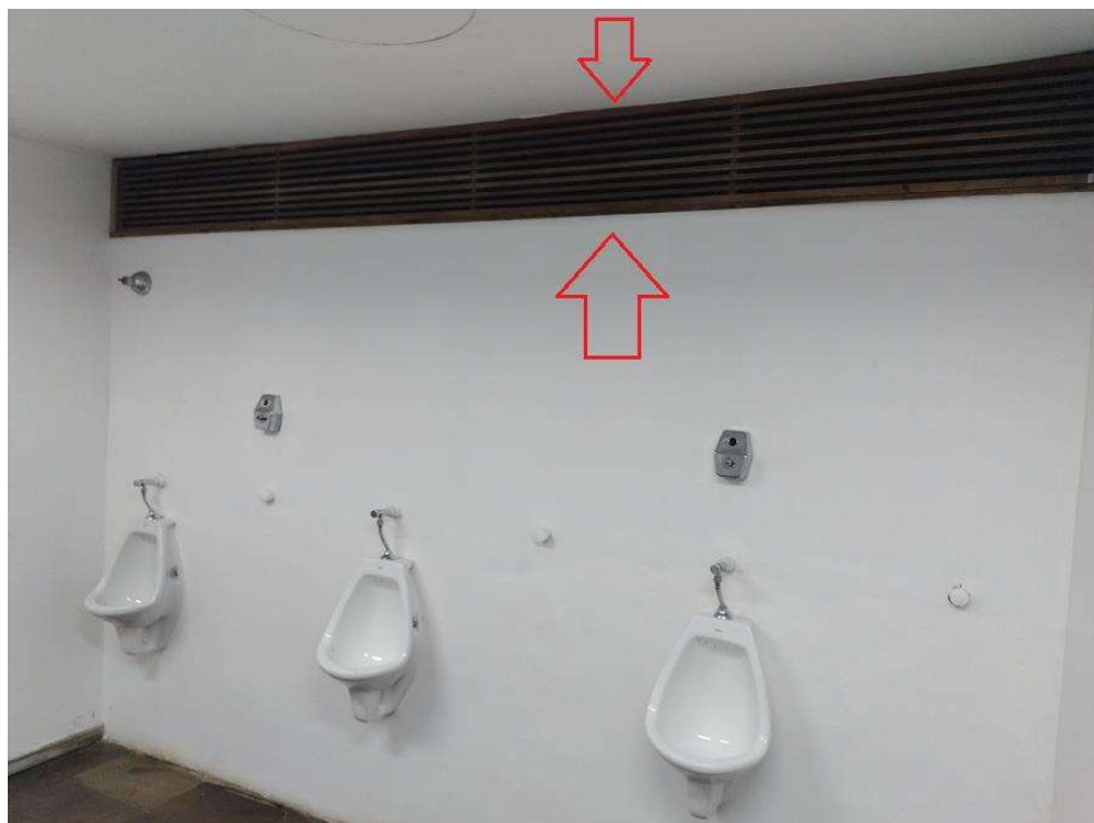
Figura 17 - Gradil a ser eliminado
