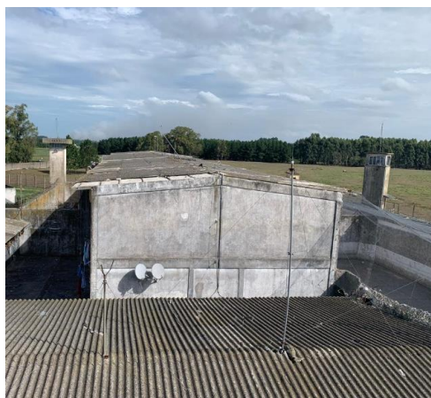
Figura 2. Visão geral cobertura Bloco 2
