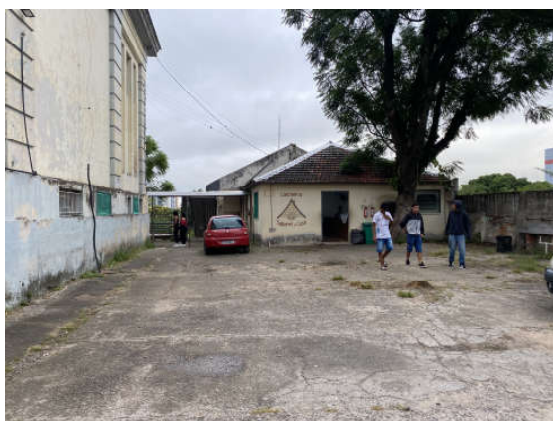
Foto 2 - Cobertura danificada - Prédio 3.
