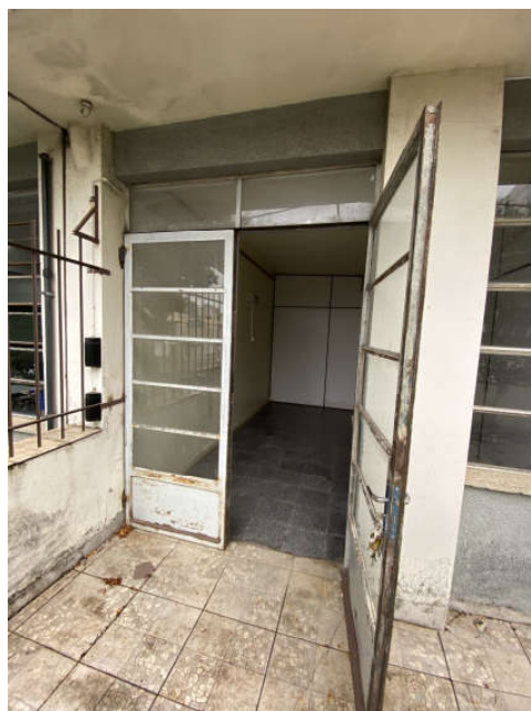
Foto 19 - Portas de acesso danificadas Prédio 5.
