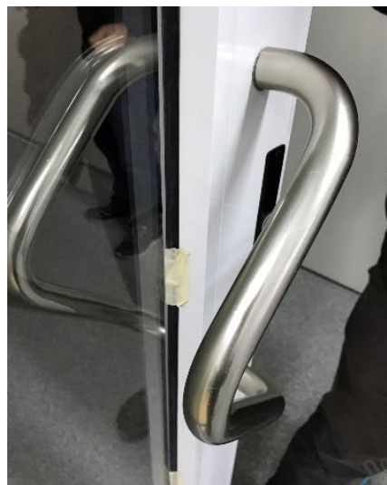
Figura 27 - Borrachas caindo ou faltando nas esquadrias (portas);
