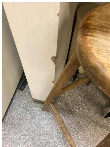
Figura 41 - Paredes danificadas e com bolhas; Schertel & Cassiano Arquitetos Associados S/S – E.mail: cassiano.arq@terra.com.br Rua General João Telles, 542/901 – CEP:90035-120 – POA/RS – Fone:33112133
