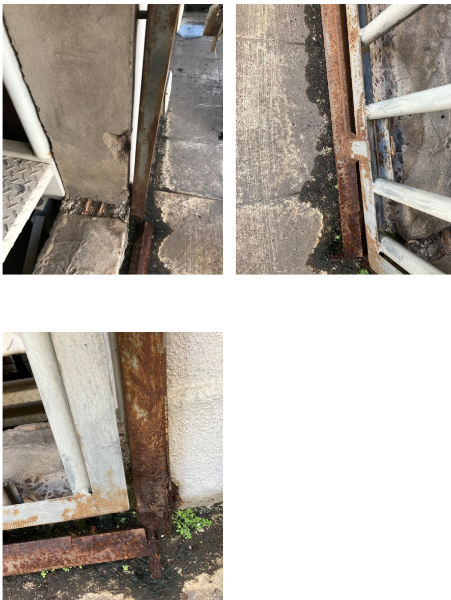
Figura 15 - Oxidação e desgaste na estrutura da porta de acesso à Casa de Máquinas;
