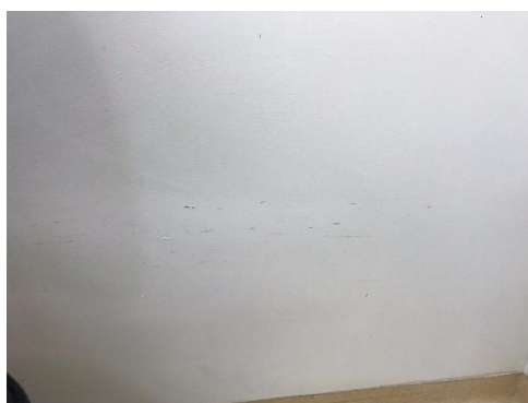
Figura 18 - Marcas de batidas nas paredes;
