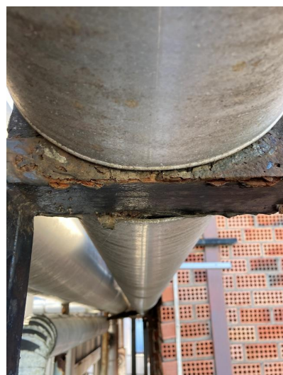
Figura 3 - Oxidação nas estruturas de suporte as tubulações;
