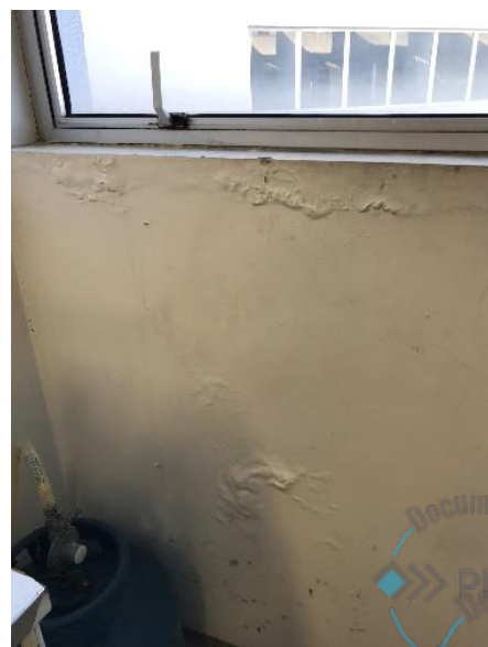
Figura 41 - Paredes danificadas e com bolhas; Schertel & Cassiano Arquitetos Associados S/S – E.mail: cassiano.arq@terra.com.br Rua General João Telles, 542/901 – CEP:90035-120 – POA/RS – Fone:33112133
