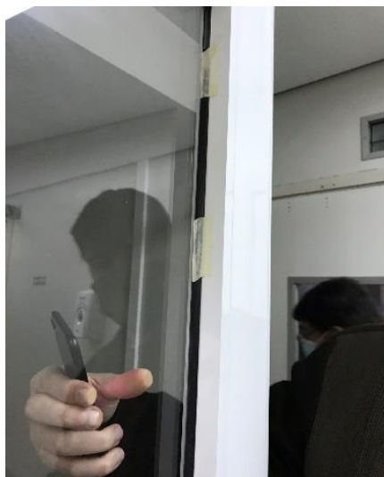
Figura 27 - Borrachas caindo ou faltando nas esquadrias (portas);
