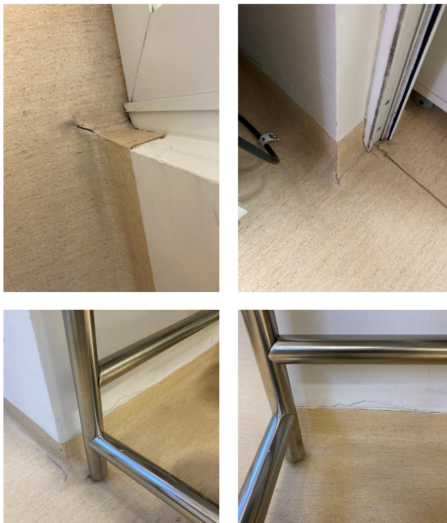
Figura 28 - Rodapés danificados e rachaduras no encontro do rodapé com a parede;
