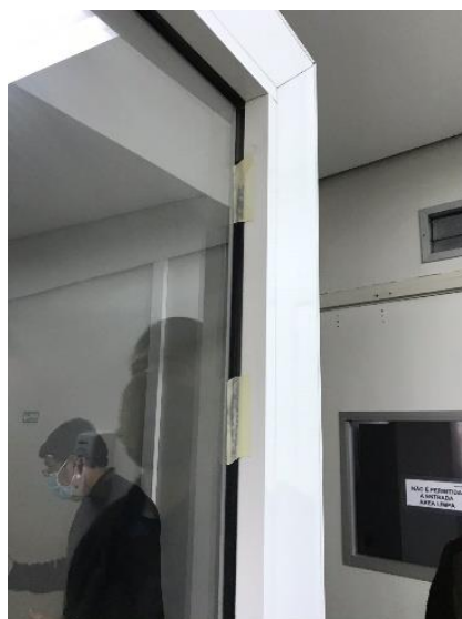
Figura 26 - Borrachas caindo ou faltando nas esquadrias (portas)
