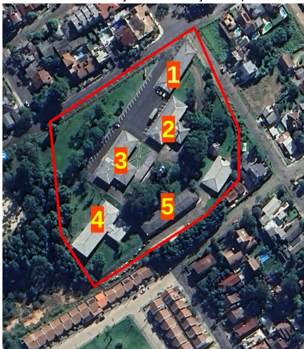
Figura 1: Imagem de satélite – Numeração e identificação dos prédios a serem reformados
