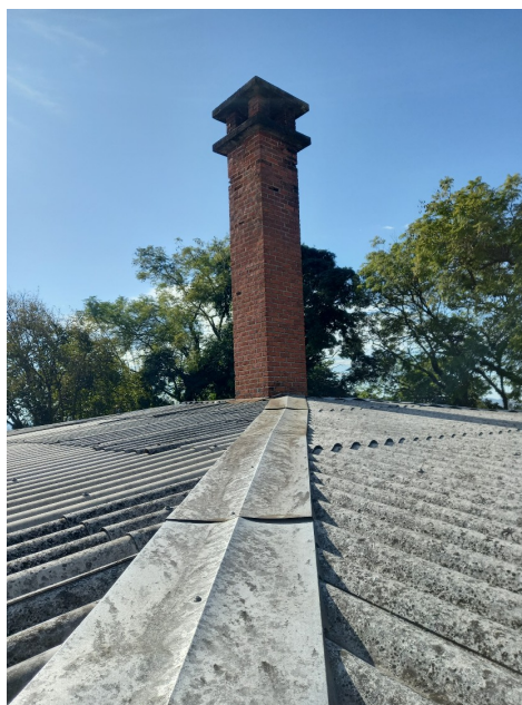
Figura 2: Chaminé da churrasqueira a demolir
