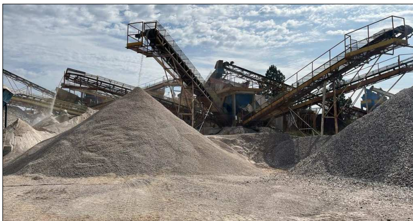
Material produzido e central de britagem
