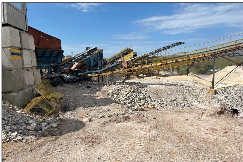
Central de britagem do empreendimento
