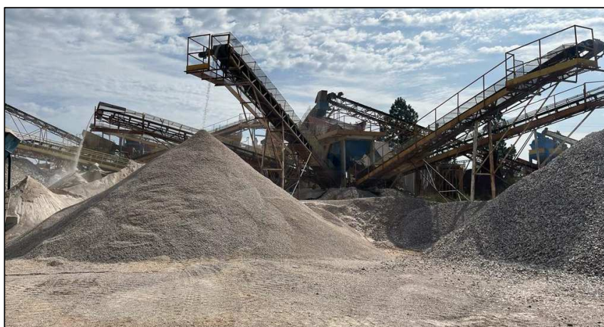
Material produzido e central de britagem
