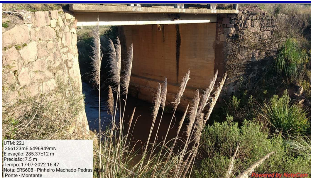
Ponte em concreto no km 14+281,50
