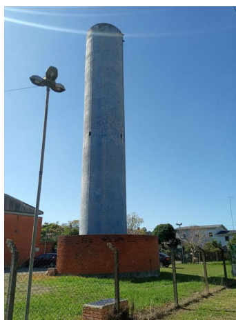
(Reservatório a demolir)
