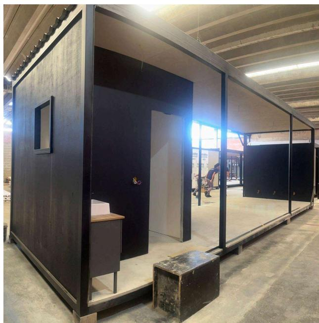
Figura 3 - Chassi em estrutura metálica, paredes externa e interna em painéis de LSF, módulo em construção na sede da empresa Box Modular. Foto da autora, realizada em 17/04/2024.
