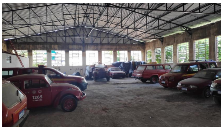
Imagem 09, 10 e 11 : interior bloco 02
