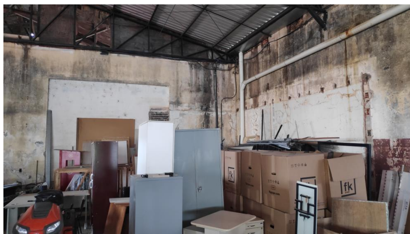
Imagem 12 e 13 : interior bloco 02
