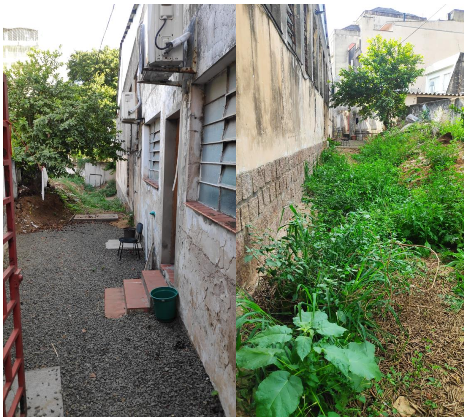
Imagem 06 e 07 : fachada sul Bloco 02
