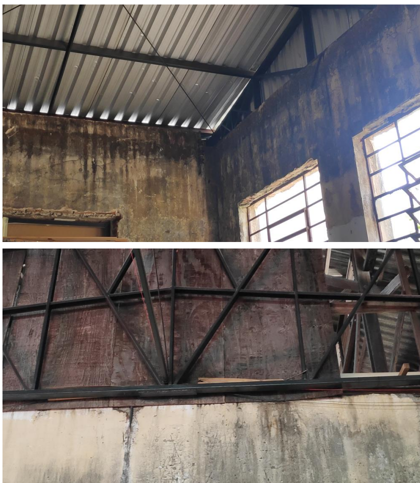
Imagem 14 e 15 : treliças bloco 02
