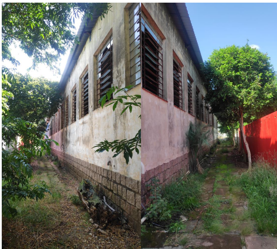
Imagem 04 e 05 : fachada sul Bloco 02
