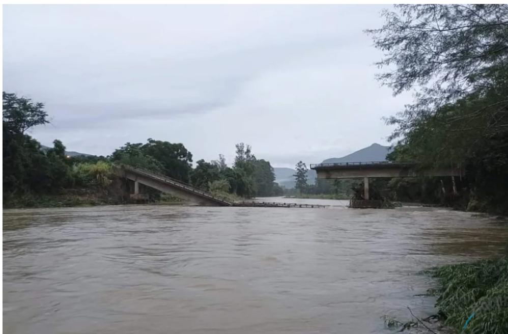
**Fig. 4:** Imagens da ponte sobre o rio Três Forquilhas sendo levada pela força da água, em 04/05/2024.
