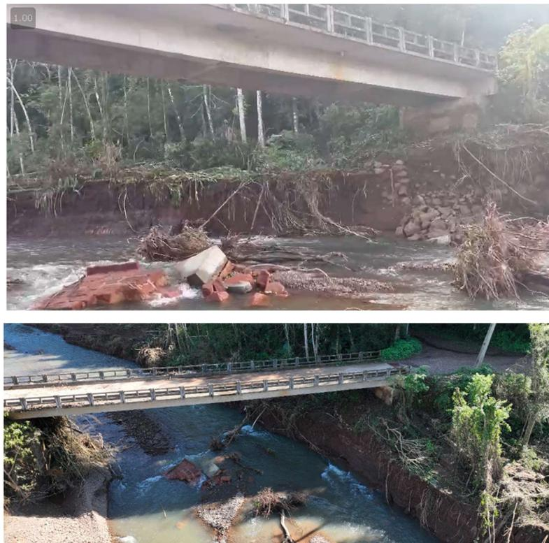
Fig. 3 e 4: Imagens da ponte após o sinistro, sem seus pilares de sustentação.
