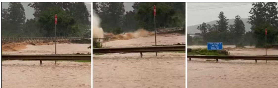
Fig. 4: Imagens da ponte sobre o rio Caí sendo levada pela força da água, em 02/05/2024.
