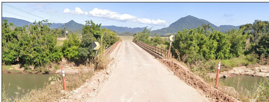
Fig. 2: Vista da ponte em concreto sobre o rio Soturno, com extensão original de 70m antes do sinistro
