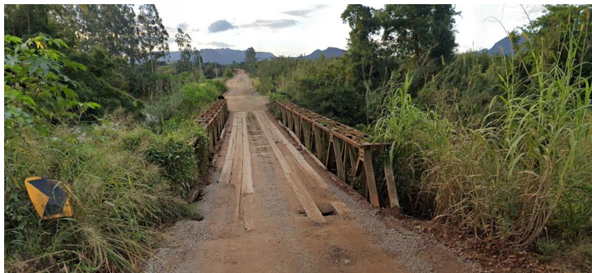
Fig. 2: Vista da ponte metálica sobre o arroio Guarda Mor, com extensão original de 50m antes do sinistro
