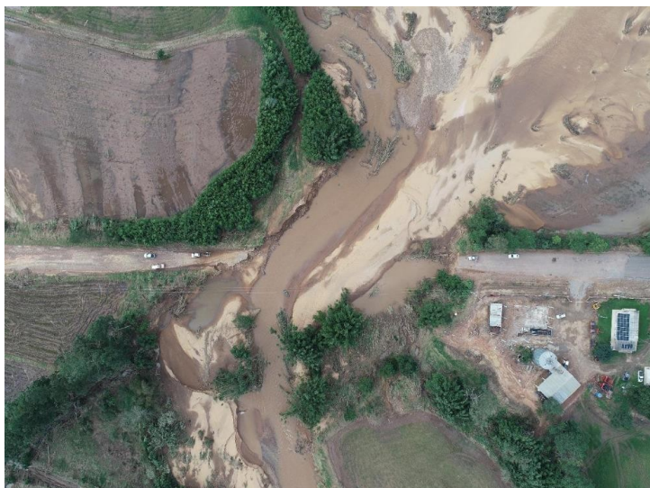
Figura 1 - Imagem de vista aérea do local da ponte com fluxo interrompido.
