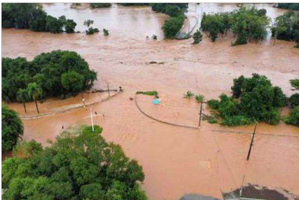
Figura 01 – Imagem da Ponte após inundações
