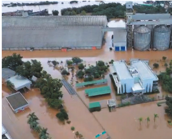
Força do grão rachou quatro paredes do armazém da Bianchini (esquerda)
