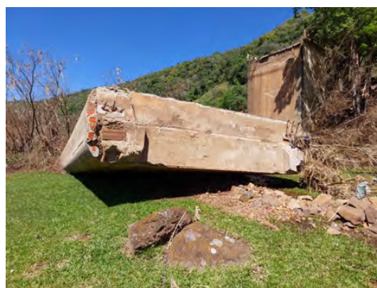
Figura 26 - Entulho da ponte
