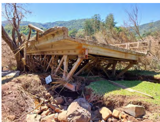
Figura 25 - Entulho da ponte
