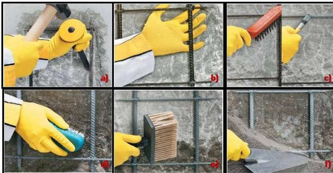
Figura 01: Sequência executiva de reforço estrutural para vigas de apoio e lajes.
