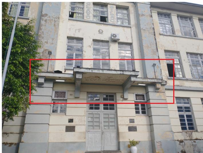
Foto 01: Marquise (lajes e vigas de apoio) a recuperar na fachada frontal (Leste) da edificação denominada como 'bloco 01' (acesso principal).
