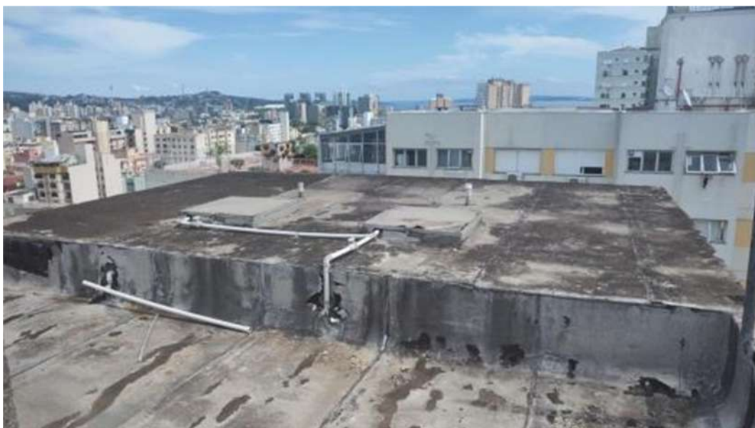
Periferia do reservatório de água: proteção de 37,25 m. x 1,30 m.
