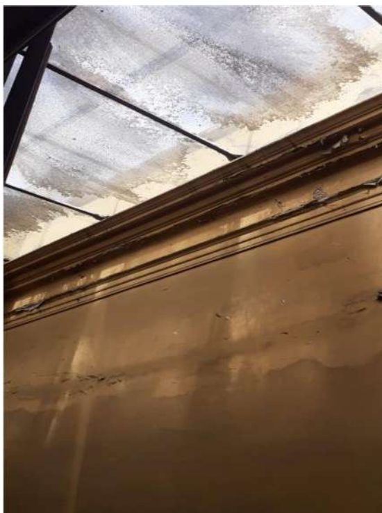
Infiltrações ocasionadas nas paredes do pavimento superior
