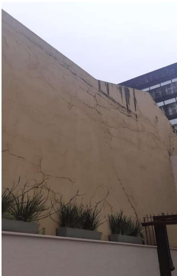
Parede interna com o revestimento deteriorado pela ação d'água
