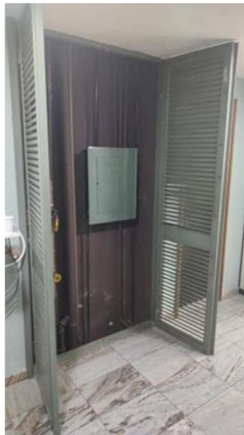
Shafts dos andares: proteção para o piso. Dimensões aproximadamente 1,20 m x 0,30 m. cada.
