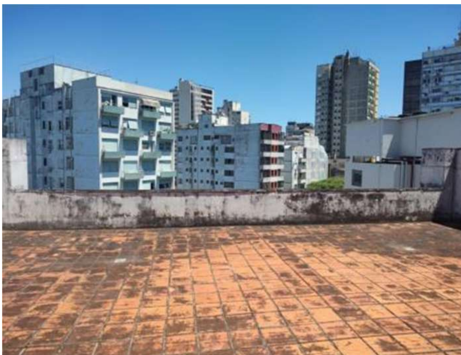
Imagem terraço - face Duque de Caxias – proteção de aproximadamente 11m lineares x 1,30m de altura (do piso até o final da proteção, descontando a altura da mureta: aproximadamente 0,85m)
