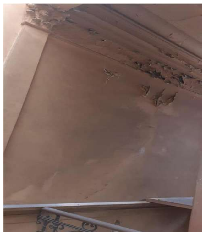
Infiltrações ocasionadas nas paredes do pavimento superior
