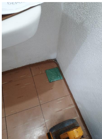
Figura 16 Ralo tapado com saco plástico.
