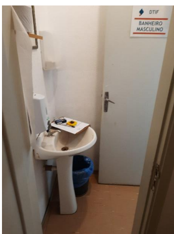
Figura 11 Sanitário Masculino com área de lavatório pequena.
