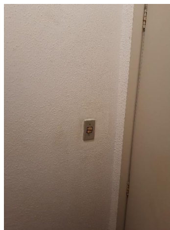
Figura 12 Interruptor atrás da porta.
