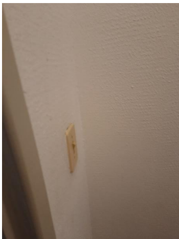
Figura 21 Textura a ser removida das paredes. Capa com teclado de interruptor a ser substituída.
