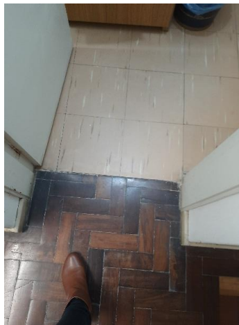
Figura 14 Soleira sem junção.
