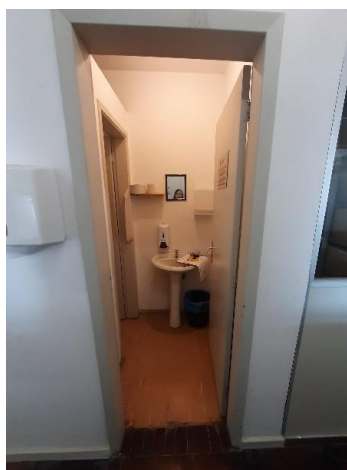
Figura 2 Sanitário Masculino DTIF.
