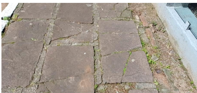
Piso do passeio no acesso a receber nova pavimentação
