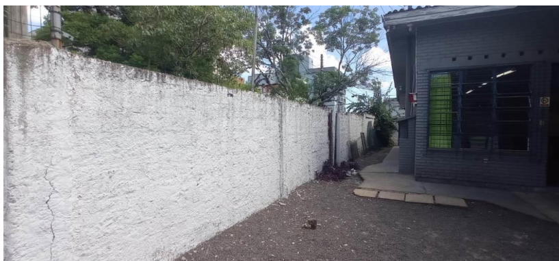
Muro a receber estrutura de concreto armado e alvenaria de grés
