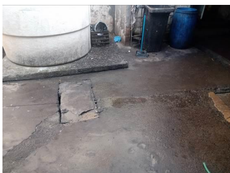
Foto 03 – Caixa de Inspeção/Poço de Visita - Pátio
