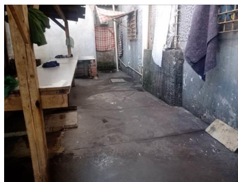
Foto 08 – Área Provável - Tanque Séptico e Sumidouro
