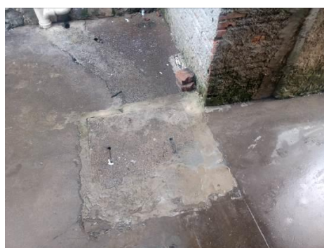
Foto 10 – Caixa de Inspeção/Poço de Visita - Pátio
