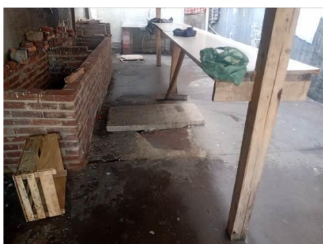
Foto 09 – Área Provável - Tanque Séptico e Sumidouro
