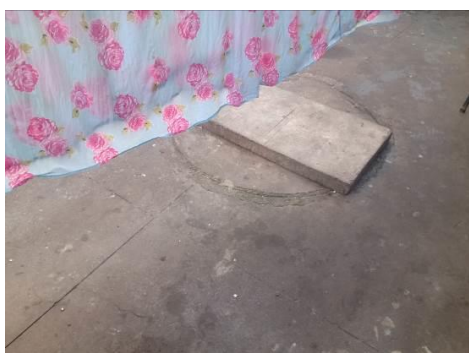
Foto 05 – Provável Tanque Séptico - Pátio
