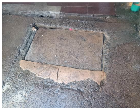
Foto 02 – Caixa de Inspeção/Poço de Visita - Pátio
