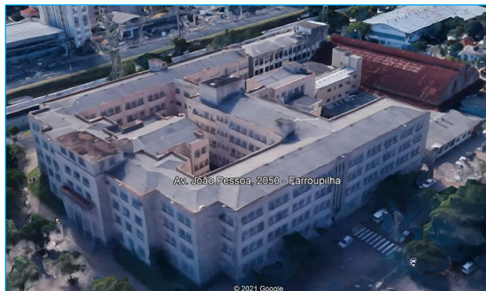
Figura 1 – Vista externa superior da edificação do Palácio da Polícia, foco do projeto de SPDA.
