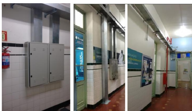
Figura 4 – Detalhes do escopo dos serviços de adequações das instalações elétricas conforme os métodos de encaminhamento dos condutores nos corredores, salas e outros setores.
