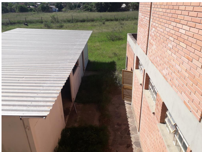
Vista do módulo de cozinha e refeitório (contêiner).
