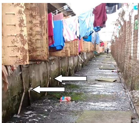
Foto 02 - Indicação de Tubulação Externa Celas
