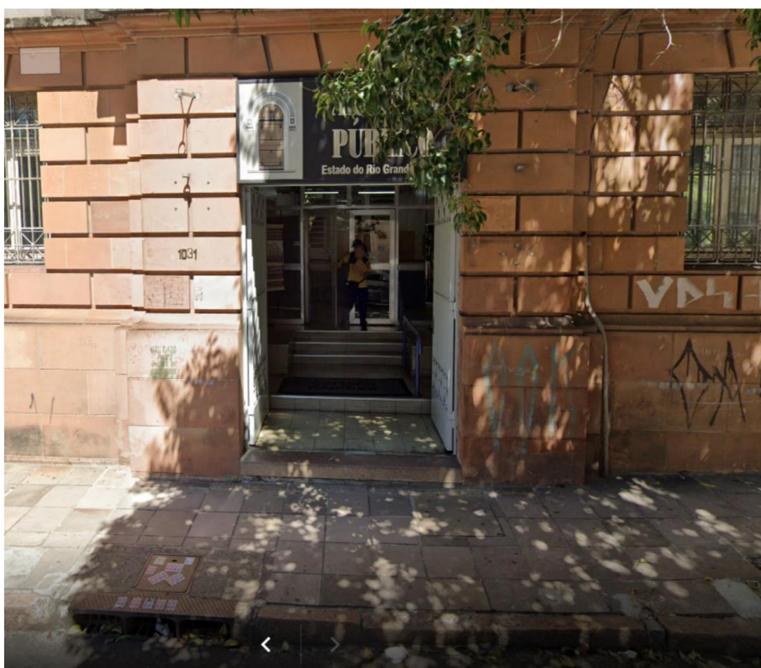
Entrada 01 da Rua Riachuelo. O primeiro degrau é um bloco de granito com altura de 17cm.
