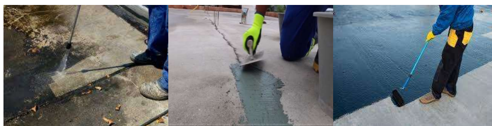
Figura 02 – Procedimento de impermeabilização da laje – imagens ilustrativas
