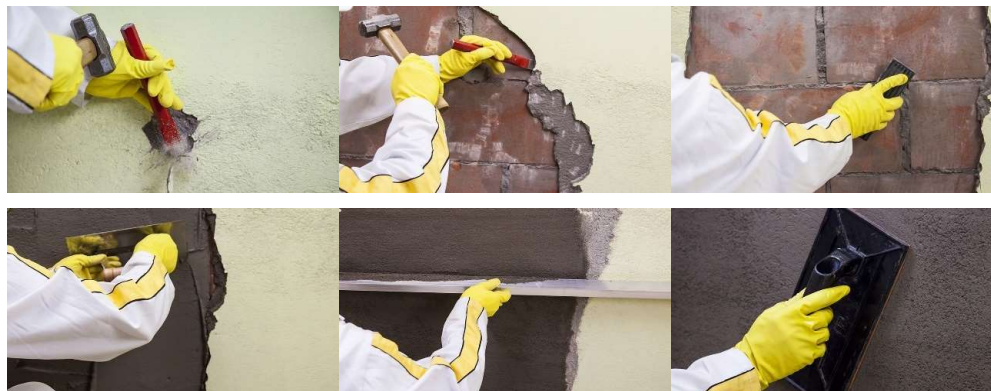
Figura 08 – Recuperação de Revestimentos de Reboco – imagens ilustrativas
