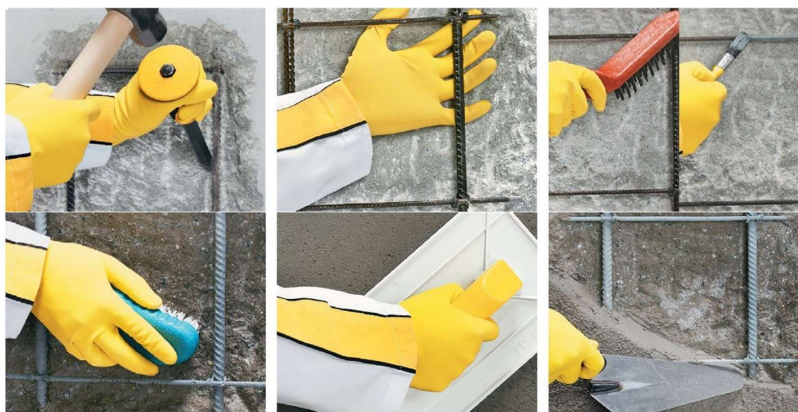
Figura 07 – Recuperação e Reabilitação Estrutural – imagens ilustrativas
