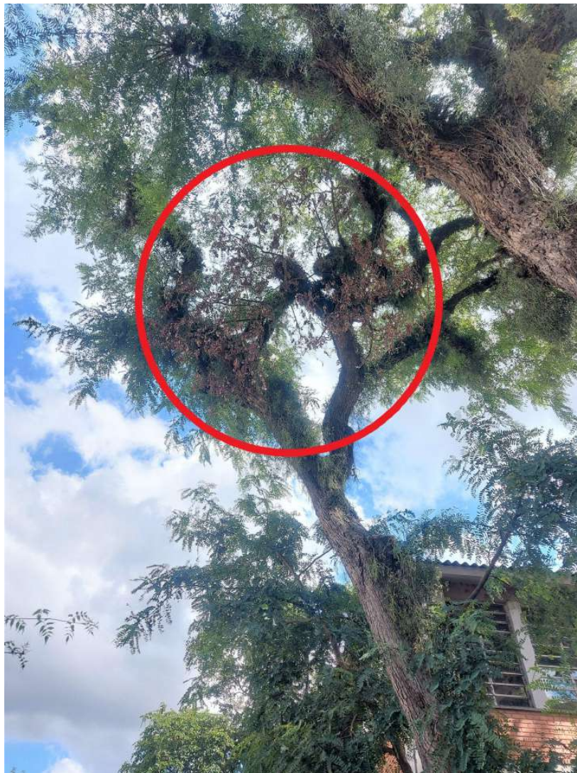
Figura 8. Presença de galhos quebrados que ainda se encontram presos parcialmente à árvore, podendo cair a qualquer momento (círculo).
