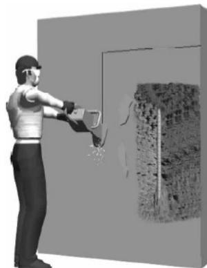
2.1.4 Remover com martetele, ponteira, marreta/talhadeira o concreto deteriorado, inclusive o do entorno da armadura corroída ou não ( $\pm 2$  cm). Remover sujeira, contaminantes, incrustações e partes soltas por hidrojateamento de alta pressão ou lixamento do substrato. Escarificar e remover por apicoamento todo concreto solto
