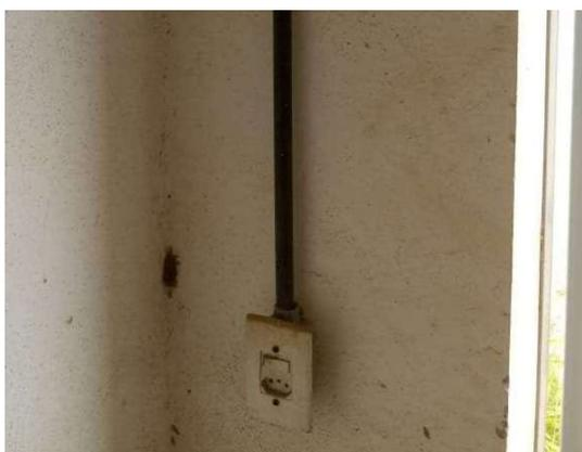
Foto 03: Tomada e interruptor do circuito interno da cabine de medição e proteção.
