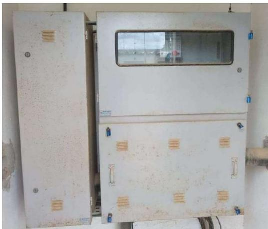
Foto 01: Caixa de medição e módulo do disjuntor.
