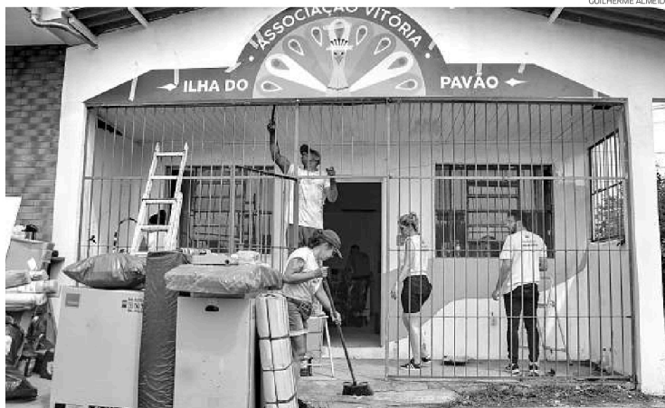
Cerca de 40 voluntários ajudaram na limpeza, recuperação do espaço, pintura, jardinagem e montagem de móveis
