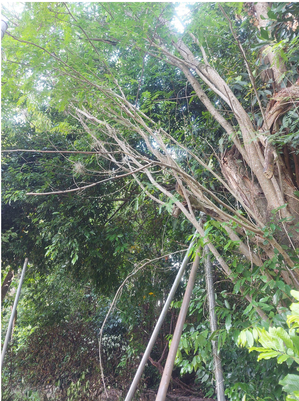
Figura 6. Detalhe mostrando a proximidade da árvore nº 2 com as estruturas metálicas do alambrado da quadra de esportes.
