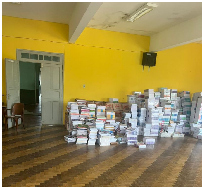
Figura 5: Pavimento superior sendo usado como depósito de livros
