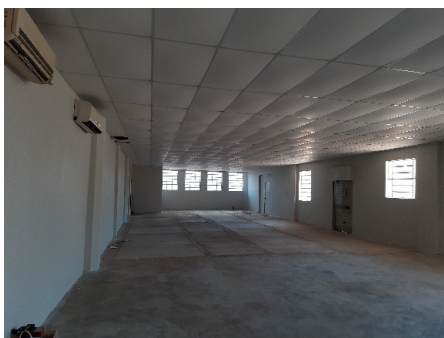
Figura 2 Sala grande com nova pintura e forro mineral sem iluminação. Figura 3 Contrapiso sem revestimento.
