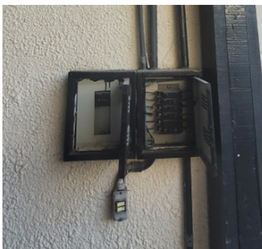
Figura 28 CD da Cozinha antigo a ser retirado e substituído.
