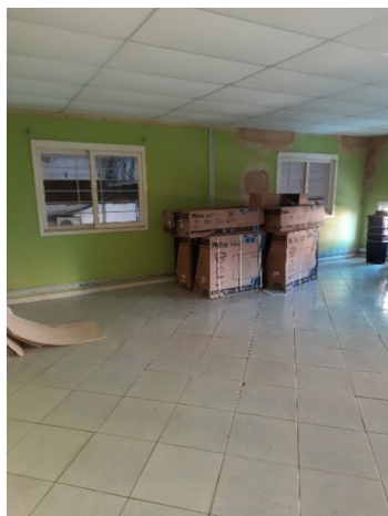
Figura 8 Sala 01: Paredes com remendos de reboco sobre a pintura, forro mineral.
