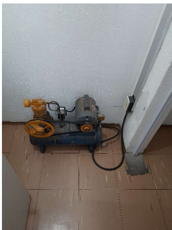
Figura 15 Compressor de ar a ser removido.
