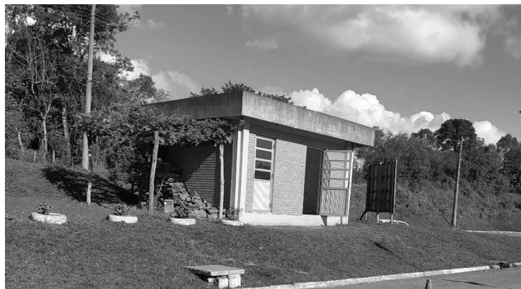
Figura 3 – Local onde ficará o gerador.
