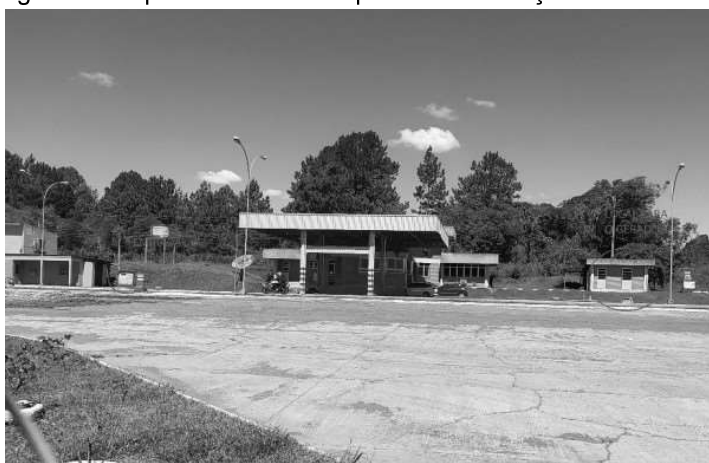
Figura 2 – Trecho entre a entrada de energia e o GMG que deverá ser aberta a vala, aproximadamente 45m.
