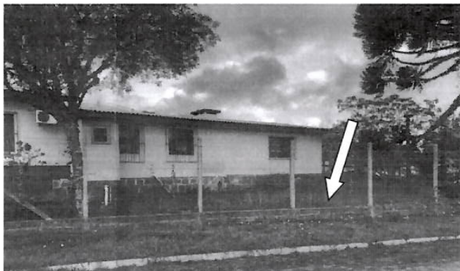
Fig. 02 – Vista geral do local aproximado da instalação do sistema. Registro fotográfico efetuado durante a vistoria em 30/05/2023..
