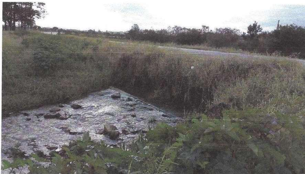
Figura 2 – Bueiro existente - JUSANTE.
