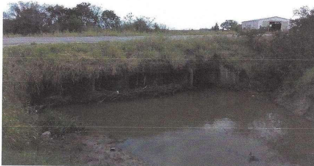
Figura 1 – Bueiro existente - MONTANTE.
