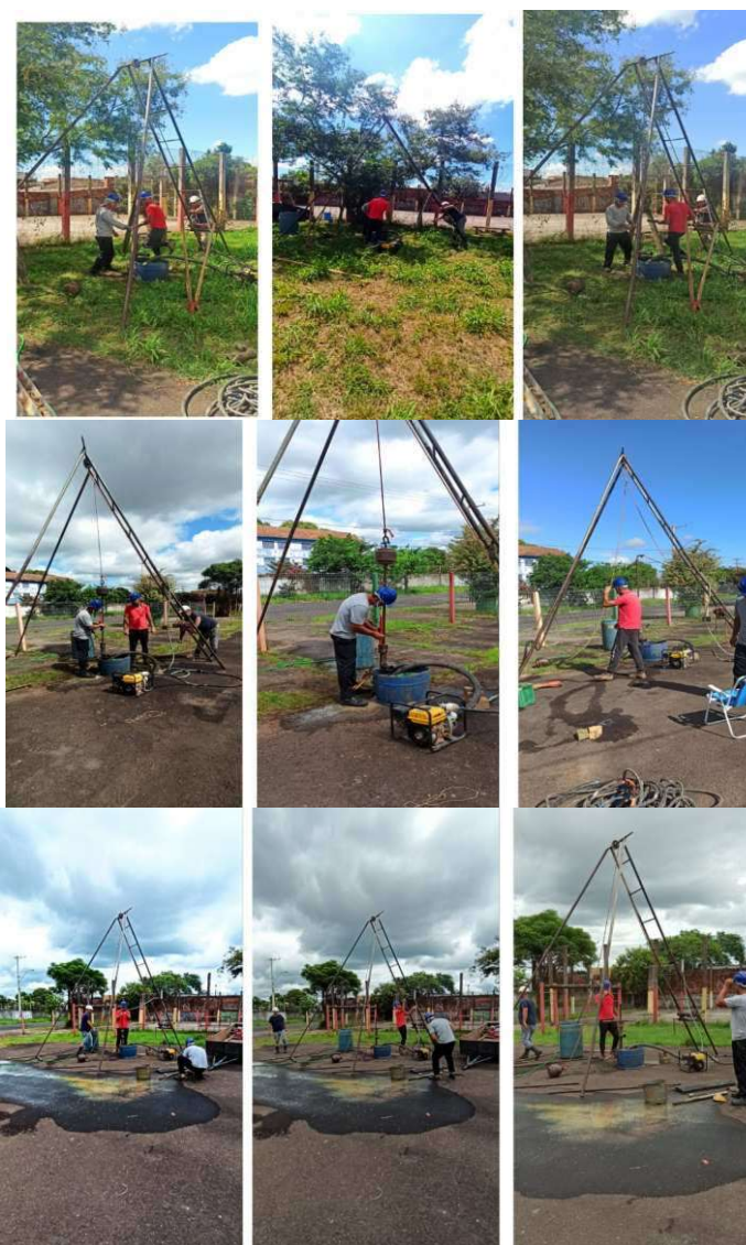
Figura 1—Execução das sondagens
