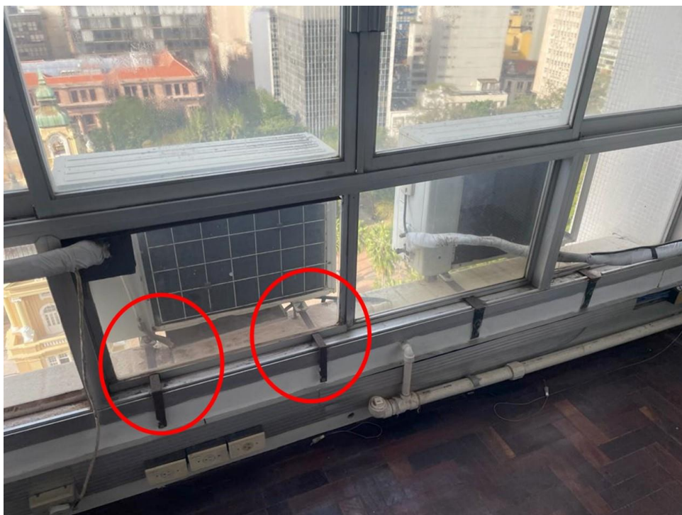
Figura 2 – Padrão de suporte nos equipamentos 07, 08, 09 e 10
