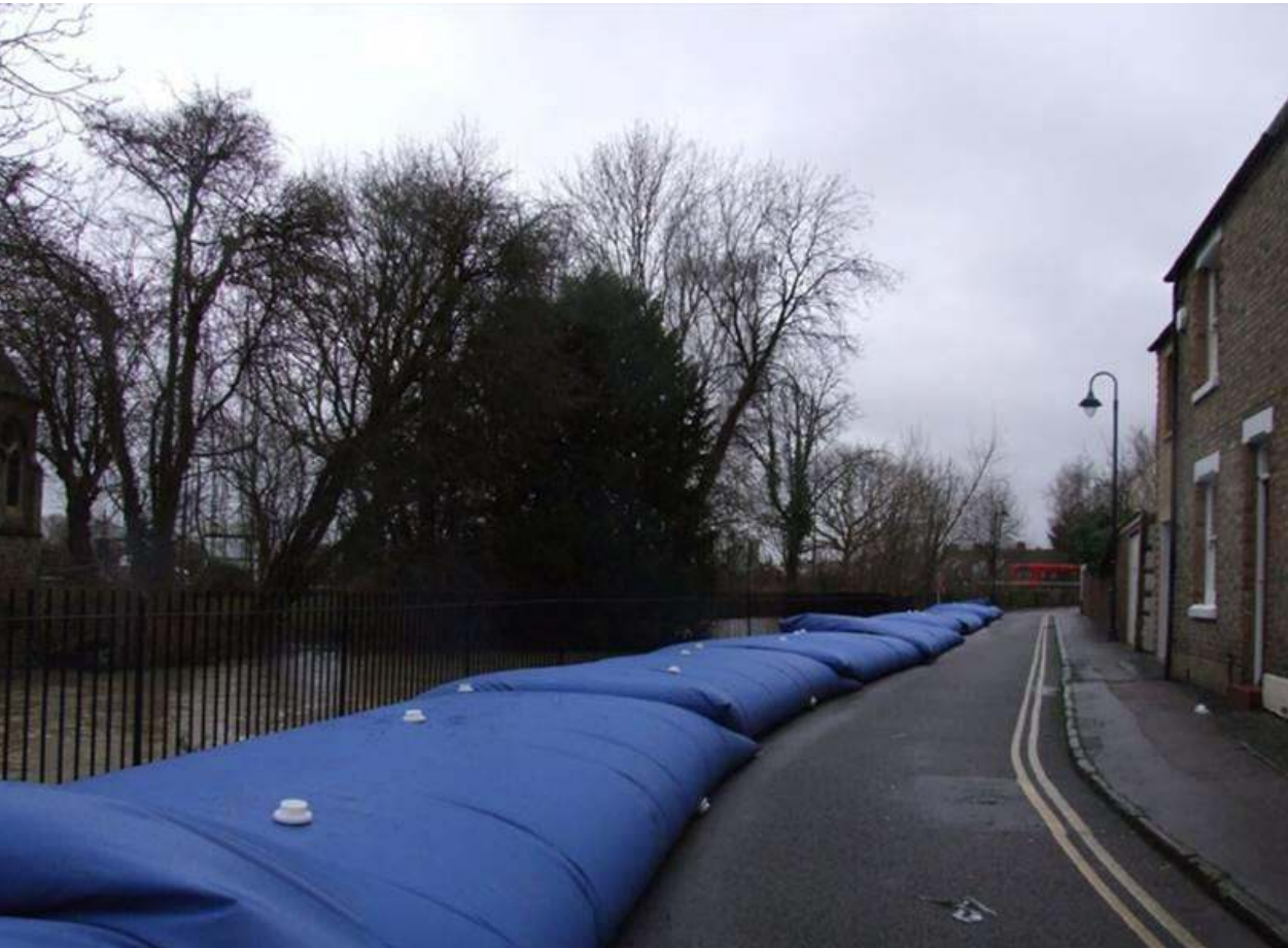
AQUABARRIER Sistema em PVC Altura Máxima = 1,80 m Não necessita ancoragem Sistema de barragem em material Reutilizável até 20 vezes Cada barragem possui 32 m de comprimento com possibilidade de conexão no local da instalação
