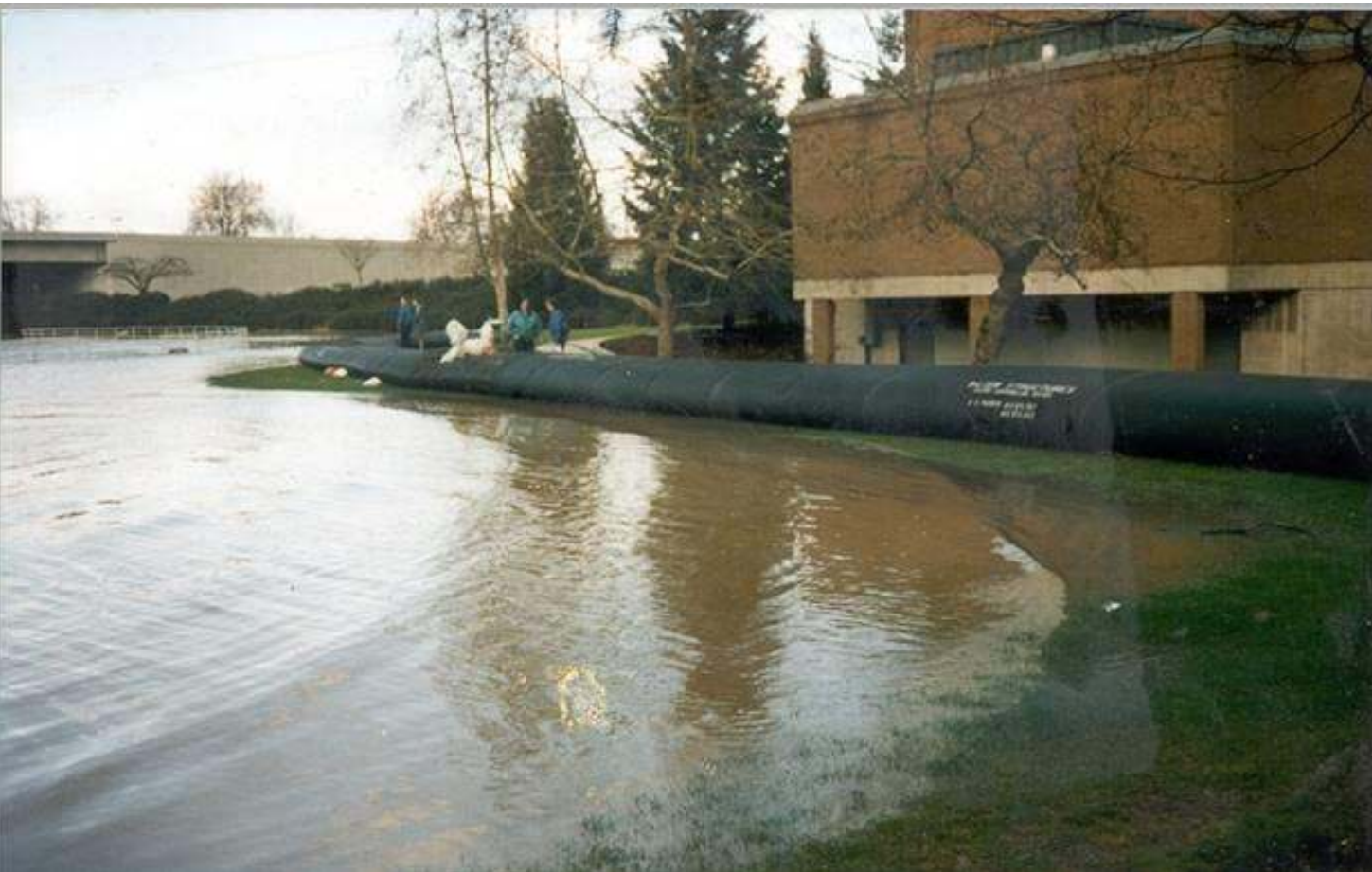
AQUADAM Sistema com preenchimento de espuma Altura Máxima = 1,60 m Não necessita ancoragem Sistema de barragem móvel composta por 02 tubos internos preenchidos com água envoltos por um terceiro estabilizador de geotêxtil polipropileno altamente resistente. Comprimento fabricado sob medida
