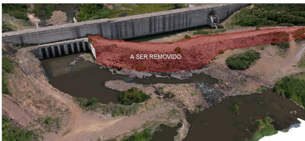
Foto 09 - ensecadeira de montante de 2a fase a ser removida
