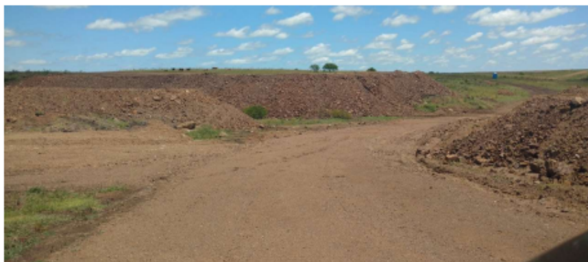
Foto 14: situação do bota-fora de montante antes do espalhamento
