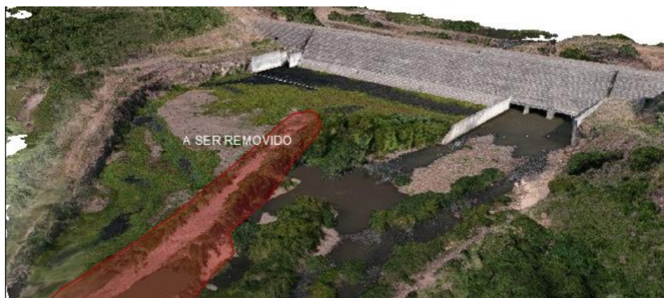
Foto 13 - resíduos do acesso da ensecadeira de jusante de 2a Fase
