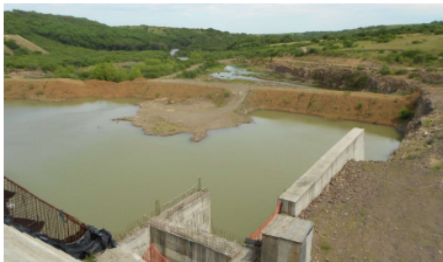
Foto 11: situação primitiva da ensecadeira de jusante de 2a. Fase
