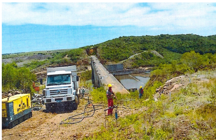
Foto 07: injeções na ombreira direita.
