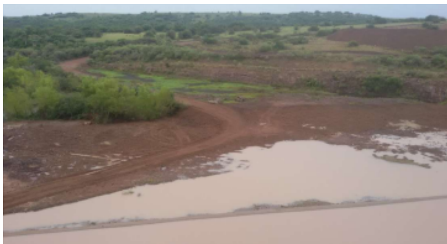
Foto 12: situação da ensecadeira de jusante de 2a. Fase no momento da remoção com visível resíduo de volume
