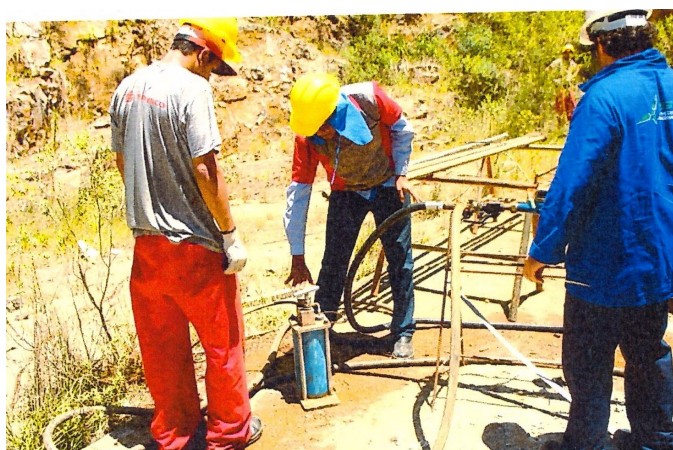
Foto 08: injeções na ombreira esquerda.
