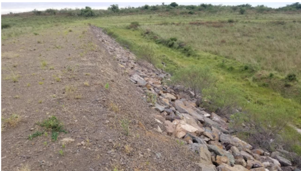
Foto 21- Visão geral do Dique 1 com enrocamento e revestimento primário
