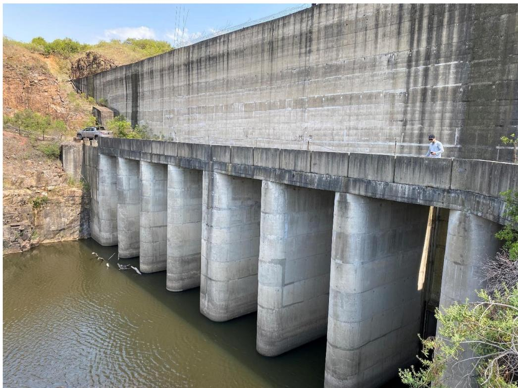
Figura 32 – Face de montante e estrutura de desvio.
